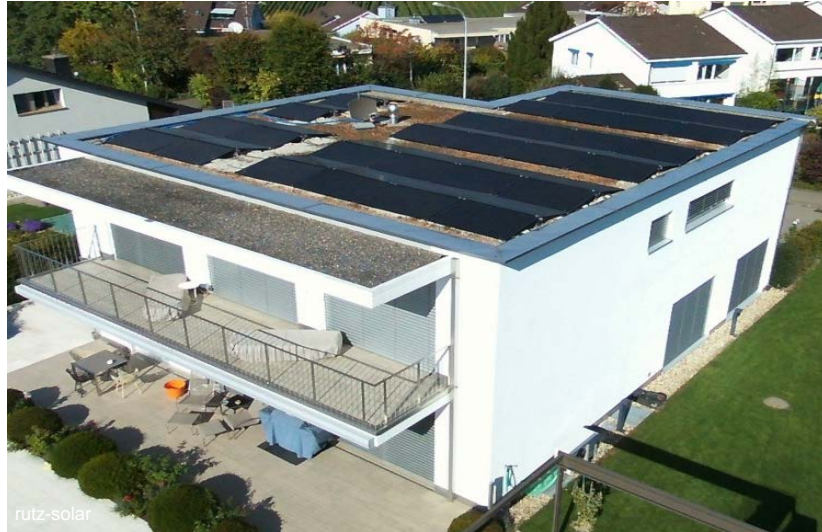
Flachdach mit Ost-West-Aufständering
