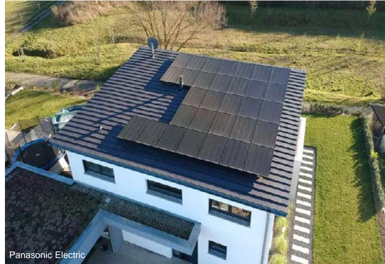
Dach mit Nord-Ausrichtung
